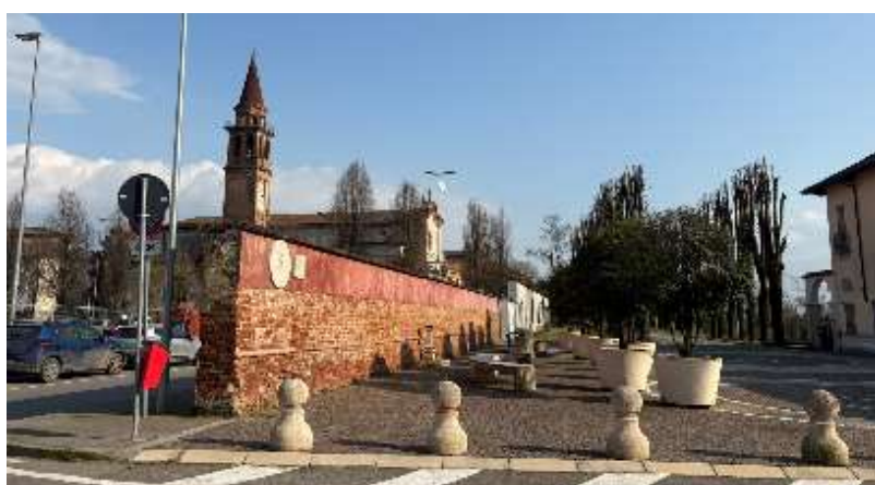
| Veduta del muro da via Balbi | Ospedaletto Lodigiano.
